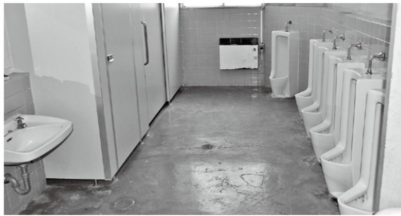
年度内に改修工事が行われるトイレ（田中小学校）
