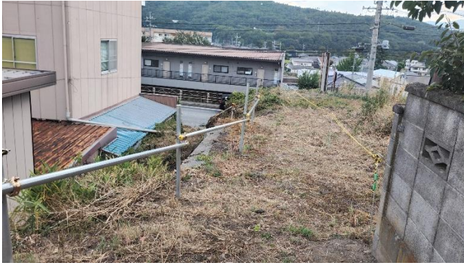
単管柵の設置の状況
