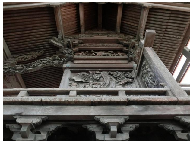
東側覆屋内部
