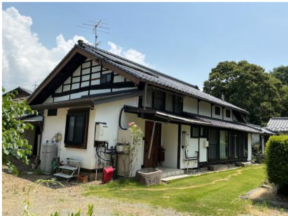
現状変更（解体工事）前 母屋
