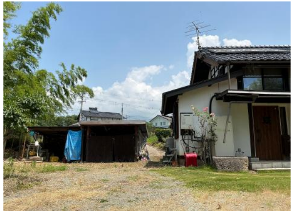
現状変更（解体工事）前 付属倉庫
