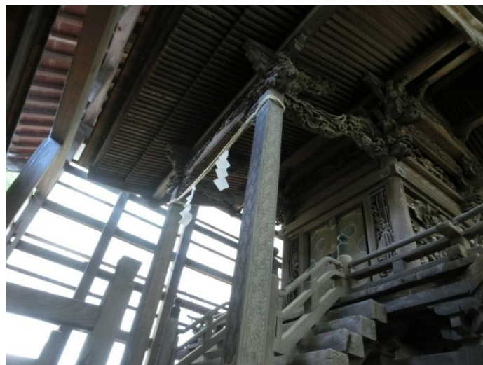
正面覆屋内部
