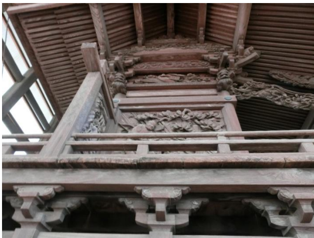
西側覆屋内部
