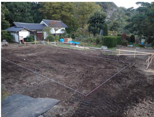
現状変更（解体工事）完了後
