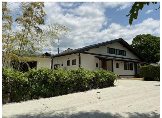
現状変更（新築工事）完了後
