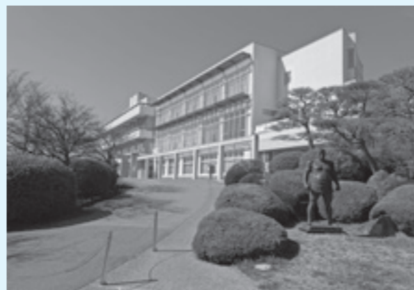
東御市役所本庁舎
