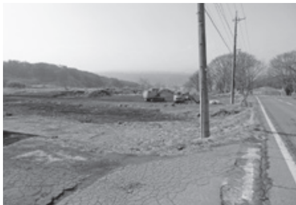
宿泊交流拠点施設予定地の既存建物解体撤去現場
