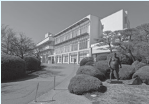
東御市役所本庁舎
