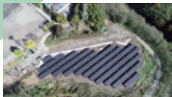
▲北御牧グラウンド周辺に設置された太陽光パネル
