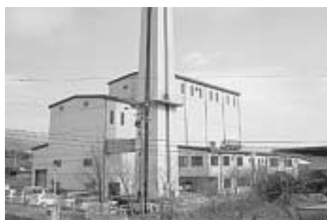
▲工事が行われる東部クリーンセンター
