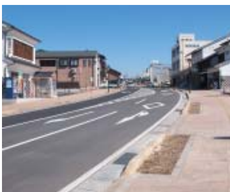
▲都市計画道路として整備された田中商店街
