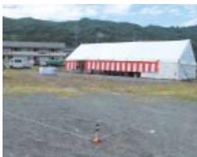
▲羽毛山団地の工事予定地
