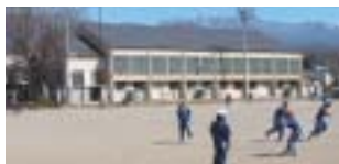
▲建て替えられる田中小学校体育館
