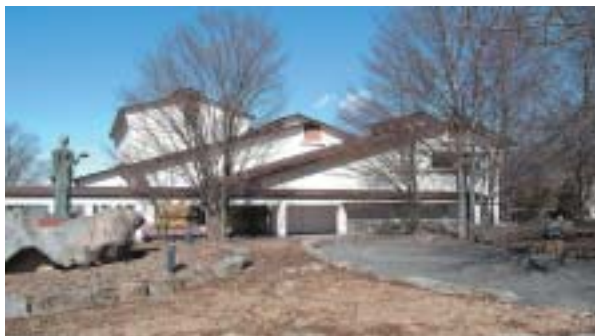
丸山晚霞記念館建設予定地（東御市文化会館東〔手前〕側）
