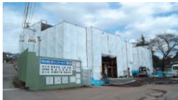
建築中の和コミュニティーセンター
