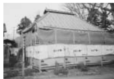
伝統的建造物群保存事業により海野宿の街なみとして改修された
