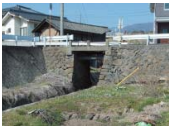
▲接続予定地の平沢橋
