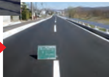
▲完成したバイパス
