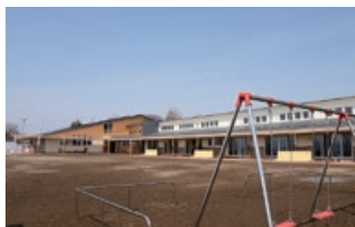
▲完成した和保育園新園舎
