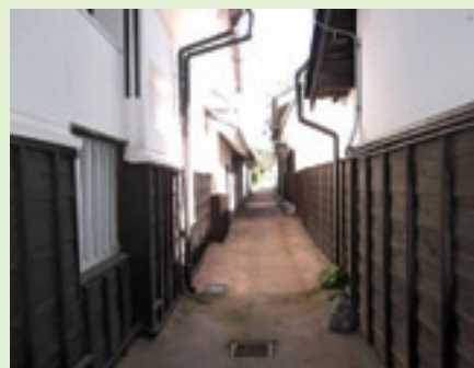
▲本海野水路新設工事
