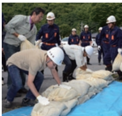
▲水害に備えるための土のう積み訓練
