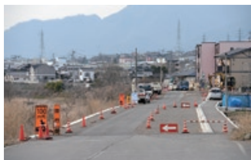
▲工事が続く海野バイパス
