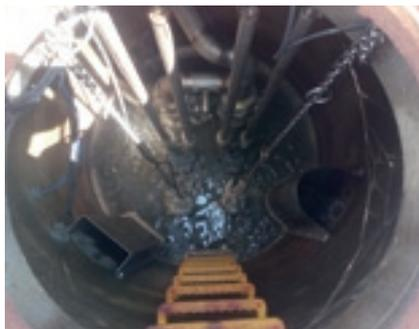
▲圧送式マンホールポンプ(低地にあるマンホール内の汚水を汲み上げる施設)
