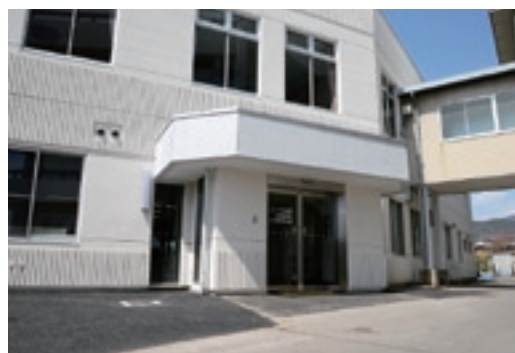
▲改修工事を終えた勤労者会館
