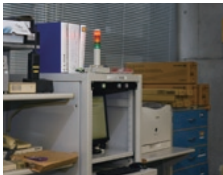
①J-アラートで受信後、自動起動機が作動
