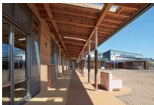
▲完成した滋野保育園新園舎
