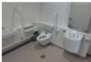
▲多目的トイレ
