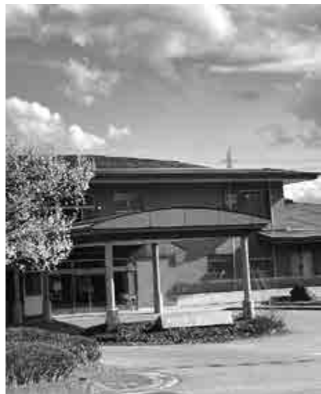
福祉避難所へ直接避難できる仕組みの検討がされている総合福祉センター
