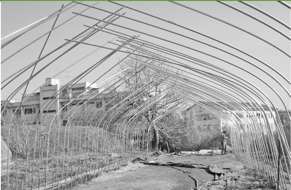
再建中のパイプハウス
