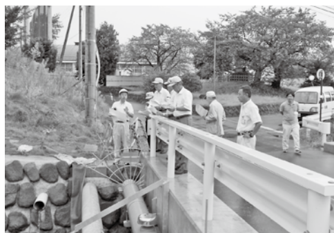
求女沢川改修工事現地視察
