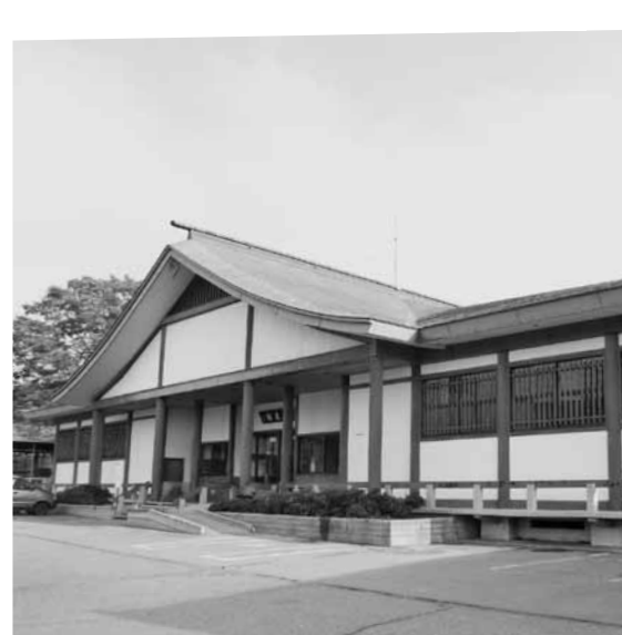
耐震化が求められる武道館
