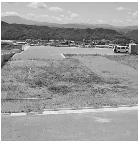
平成25年春に完成予定の滋野地区保育園建設用地
