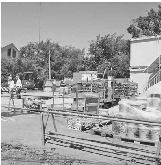
新しい道路が建設される舞台が丘会館北側駐車場
