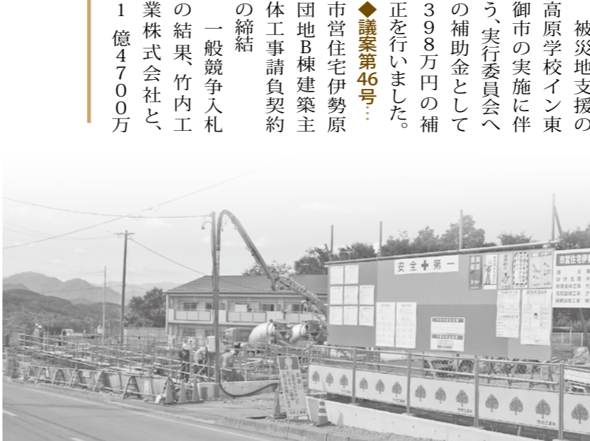
建設中の市営住宅伊勢原団地
