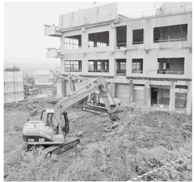
▲増改築に向けて解体工事が完了した本庁舎
