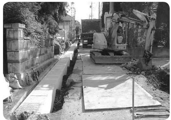
計画的に進められている排水路整備
