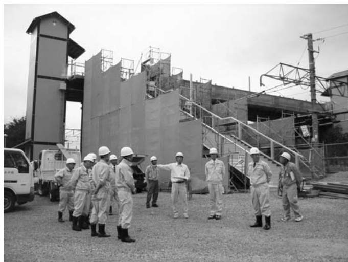
11月完成予定の田中駅南口自由通路を調査
