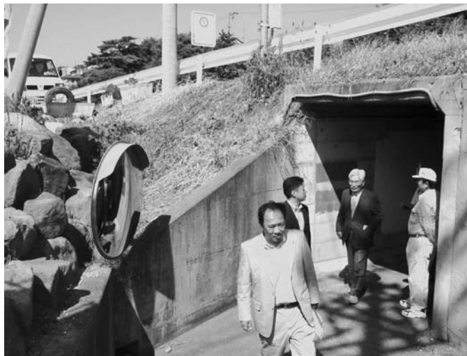
浅間サンライン(井高)の地下道を現地調査
