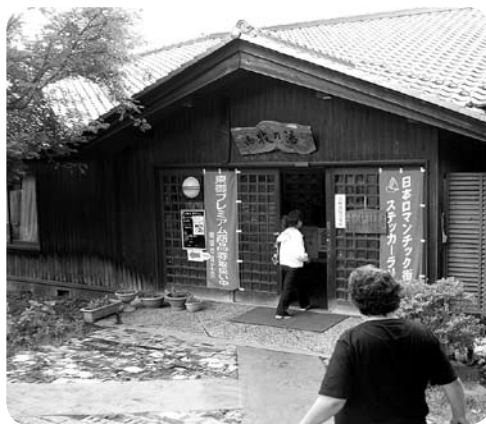
改修工事の計画が進む御牧乃湯
