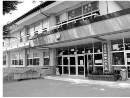
耐震補強工事が行われる田中小学校
