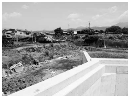
工事が始まった田中駅南口
