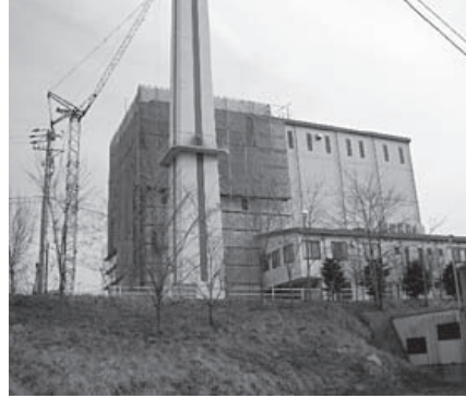
改修中のクリーンセンター
