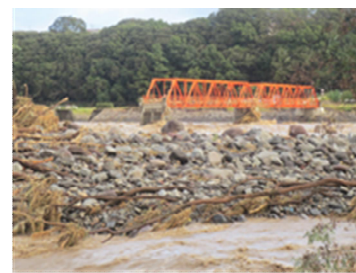
崩落した布下橋の様子
