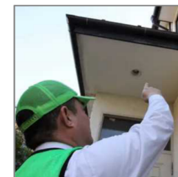
見回り時の目視点検の様子
