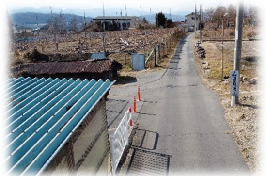
▲児童・生徒が安全に通行できるよう、地下道へ続く歩道を設置します。(市道金井片羽線)
