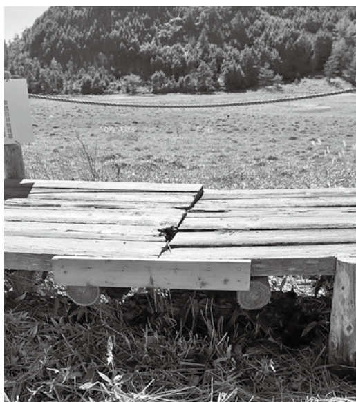
池の平湿原 木道補修の状況
