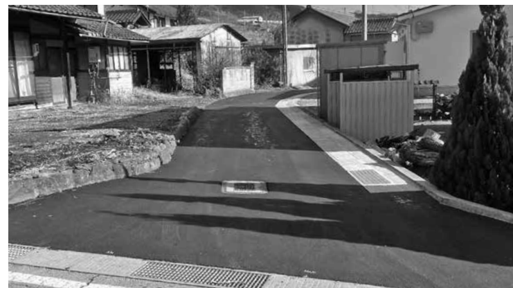
舗装修繕された生活道路
