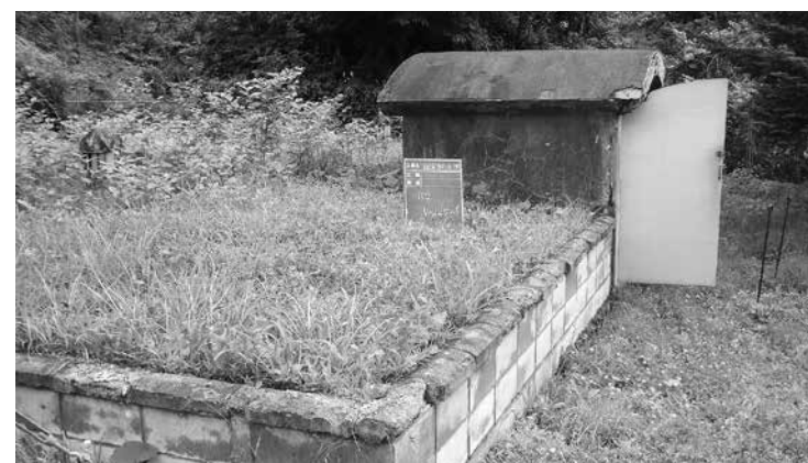
西宮水源配水池
