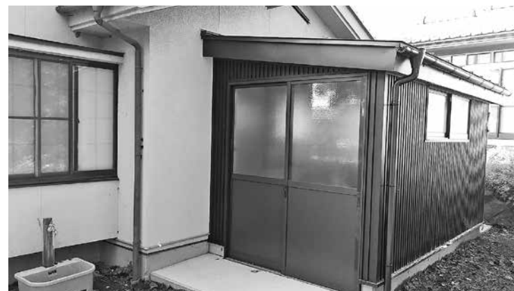
農作業器具などを入れる倉庫も設置される移住体験交流施設
