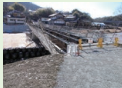
▲切久保橋の復旧工事
