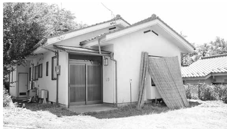
移住体験施設に改修予定の和地区教員住宅
