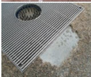
東御中央公園の「くじら噴水」について、舗装のひび割れ等が発生しているため、現在改修工事を実施しています。
