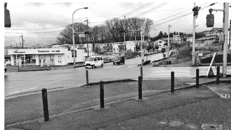
通学路に設置された防護柵
