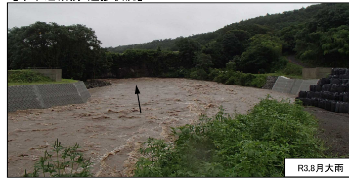
【本下之城橋 進捗状況】
