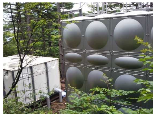
湯の丸配水池
