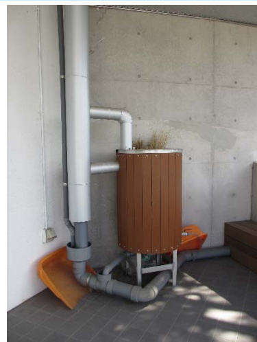
❁ 雨水貯留槽
