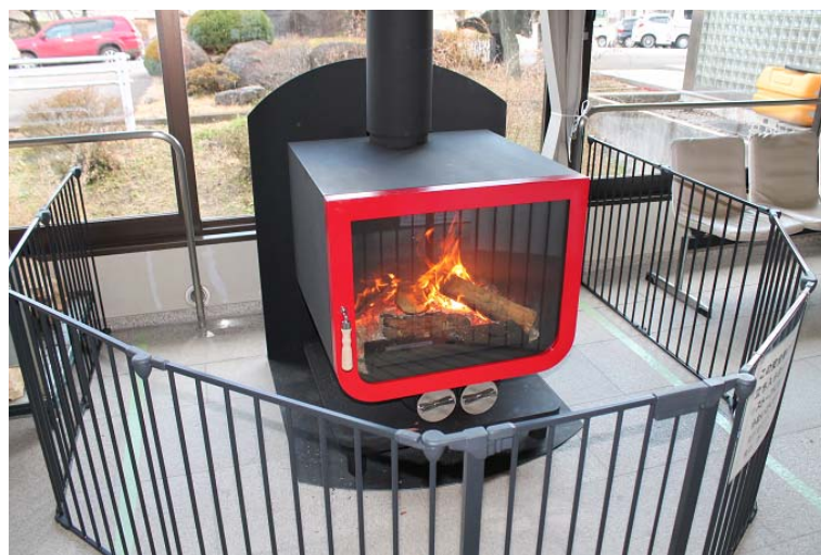
✿ 総合支所（北御牧支所）に導入した薪ストーブ
