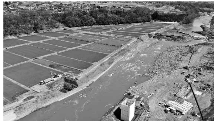
工事が進む布下橋と転作中の水田
