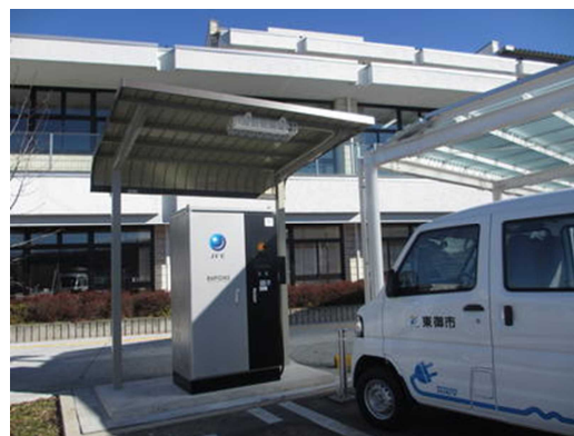
✿急速充電設備と電気自動車（右）
