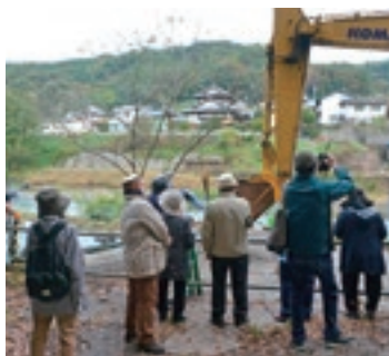
▲切久保橋流失現場
