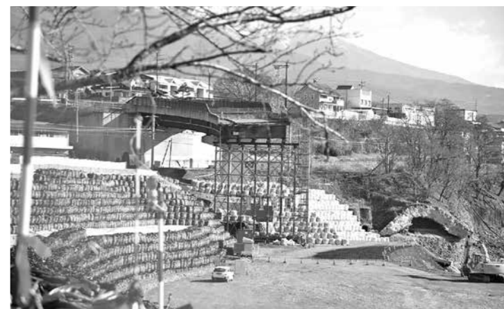
早期の完成が望まれる海野宿橋
