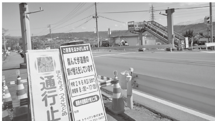
6月完成予定の歩道橋
