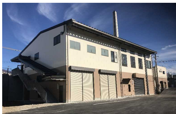
生ごみリサイクル施設「エコクリーンとうみ」
