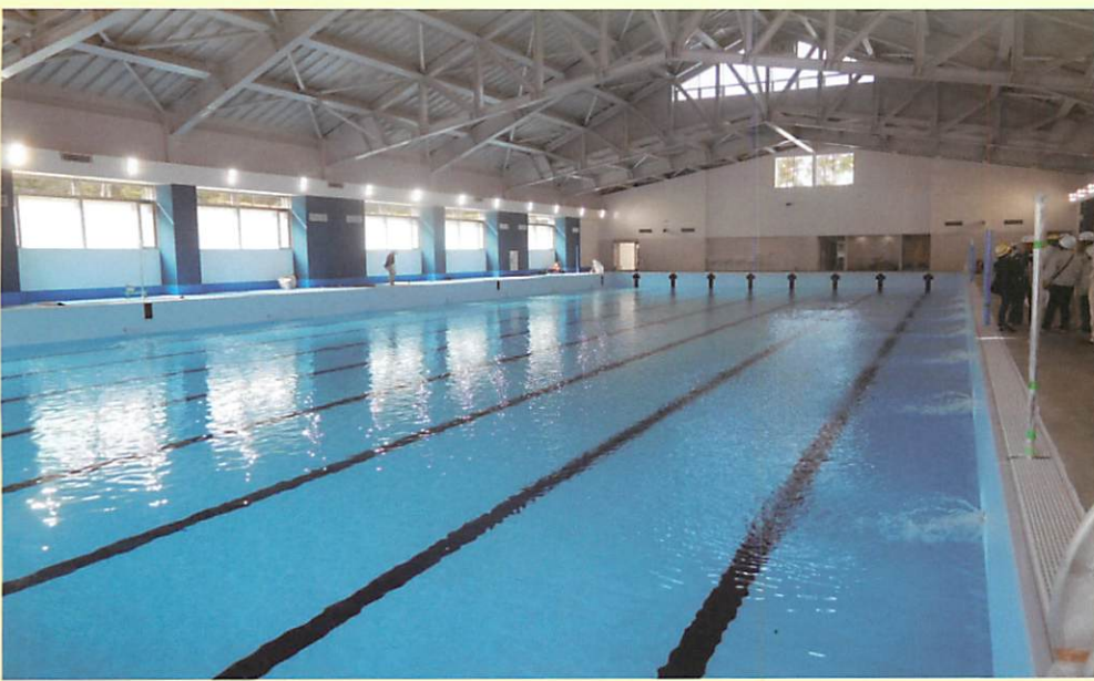
完成間近の湯の丸特設プール
