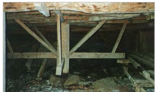
写真：回り舞台の床下の構造（奈落）
