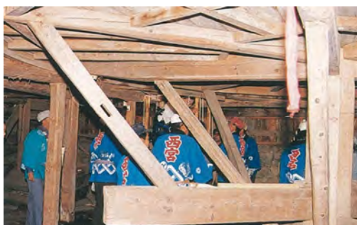
写真：回り舞台の床下の構造（奈落）
