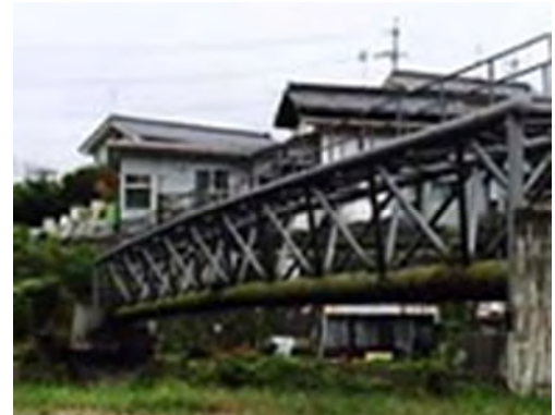
写真：鹿曲川を渡る水管橋
