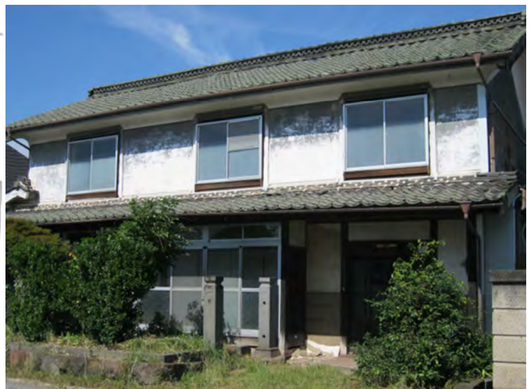
写真：空き家となり老朽化の進んだ建物（主屋正面）
