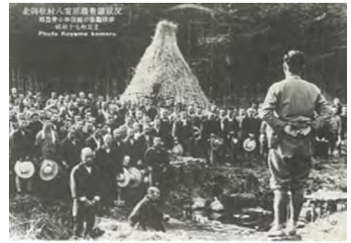
写真：八重原堰普請（昭和17年5月）
