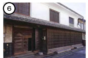
写真：明治時代の町家・塗家造り
