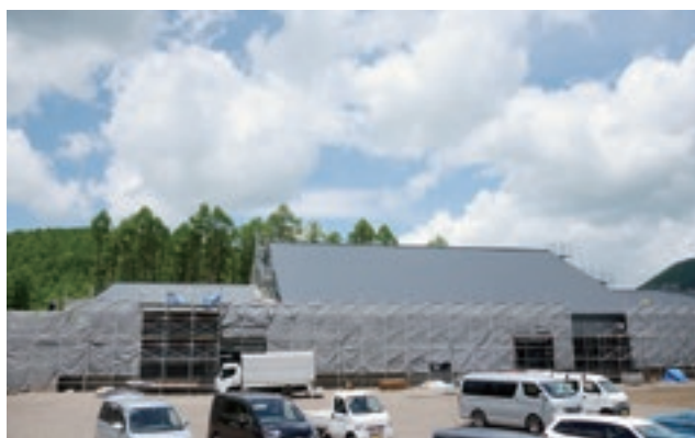
▲建設中のプール外観
