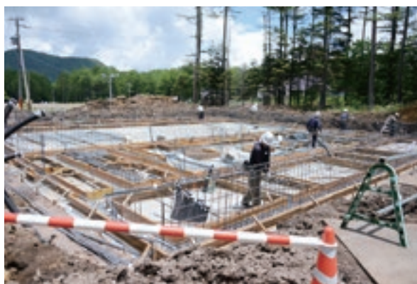
▲アスリート食堂（建設中）
