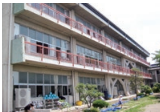
▲室外機には、事故防止のため、防護パネルを取り付けました。
