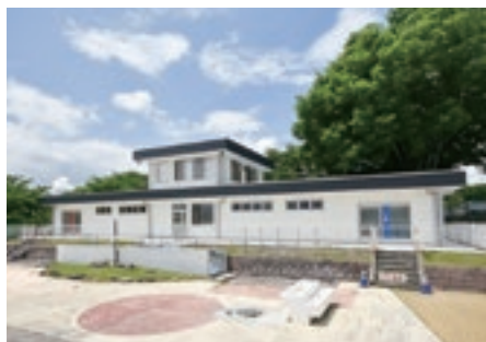
▲新しくなった管理棟
